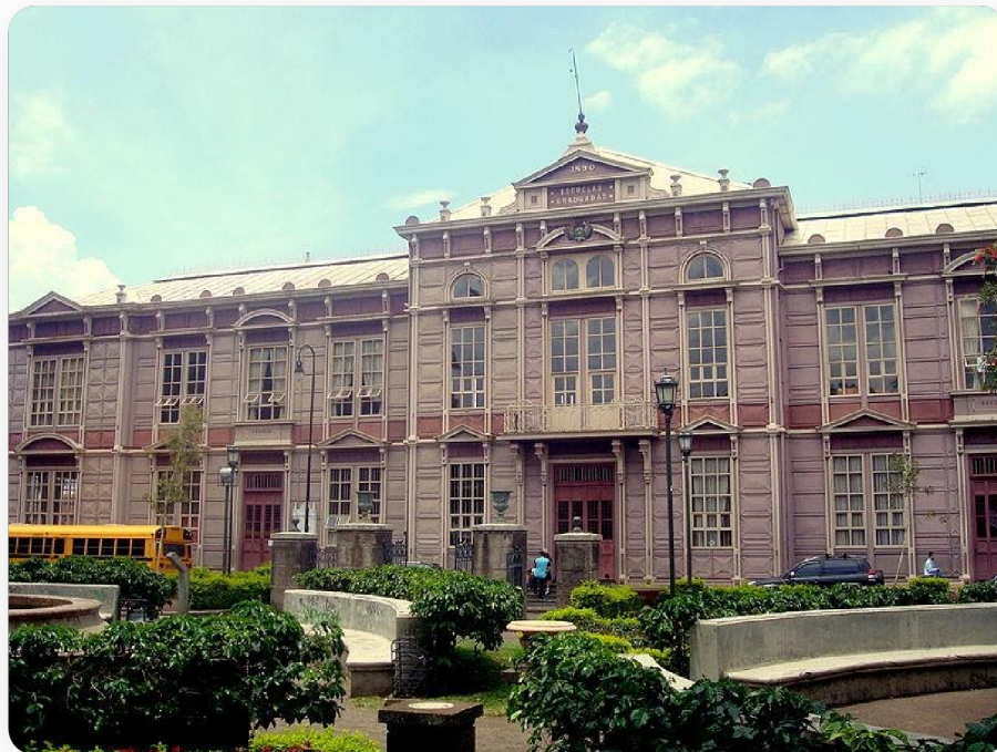
Façade de l'édifice métallique
